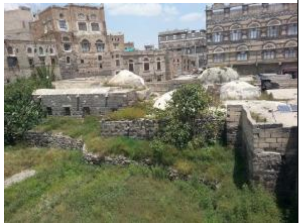
لوحة (2) الواجهة الجنوبية
